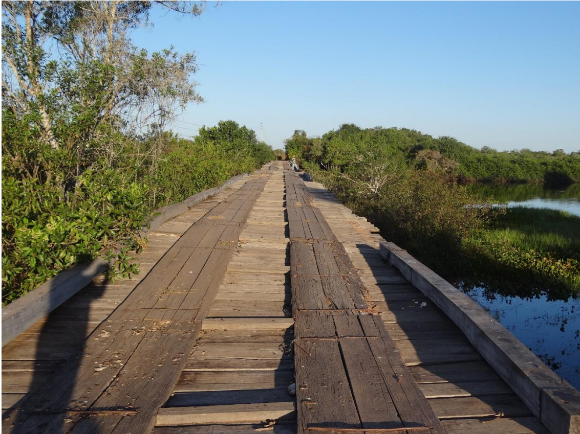
Figura 10: Antiga ponte de madeira sobre o rio Mutum, importante para o acesso à comunidade de São Pedro de Joselândia
