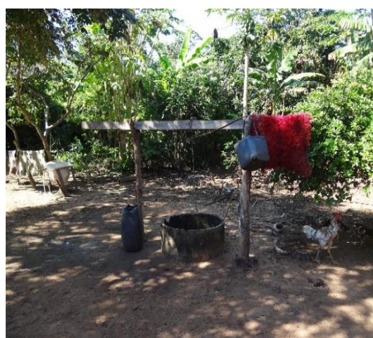
Figura 17: Poço Caipira Manilhado em Joselândia
